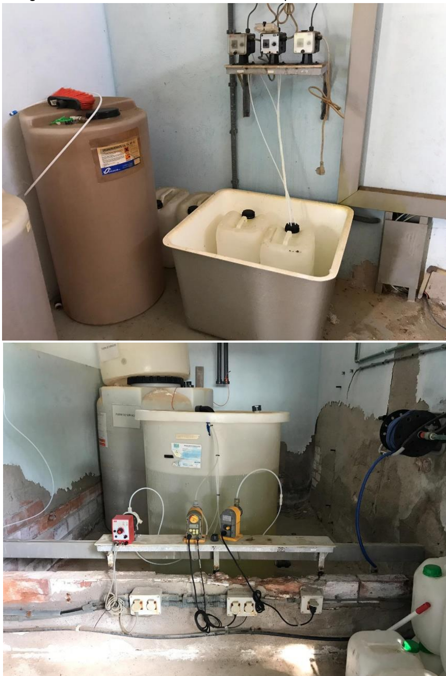
Fotografia 9. Dosificadors del desincrustant i de l'hipoclorit sòdic
