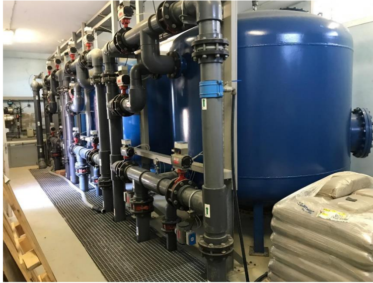
Fotografia 7. Sistema de filtres
