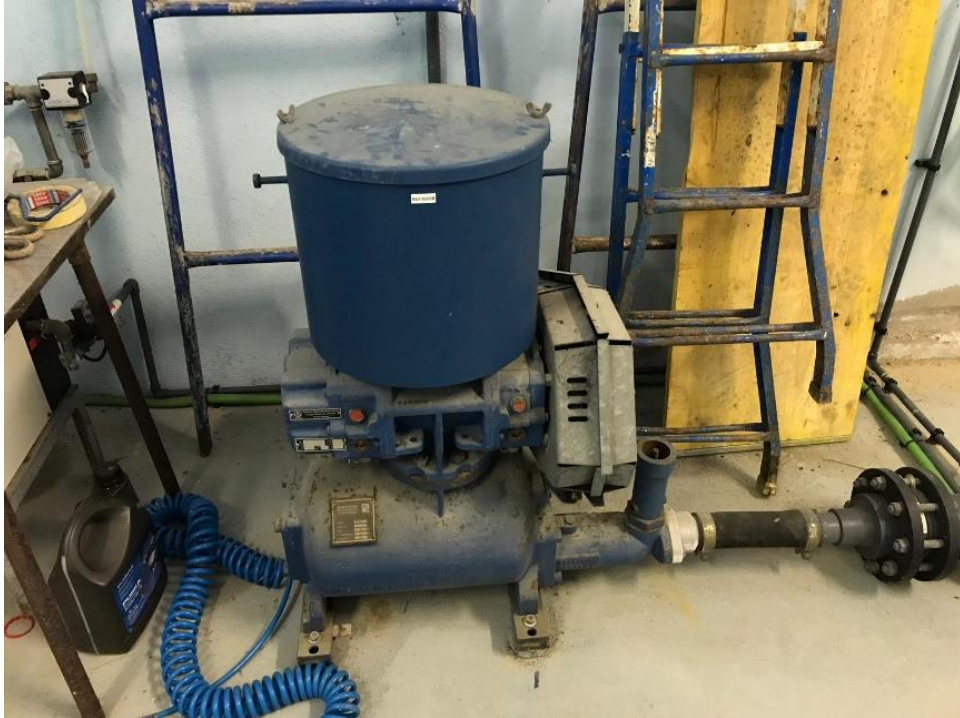
Fotografia 8. Sistema d'aire comprimit i compressor per al manteniment dels filtres
