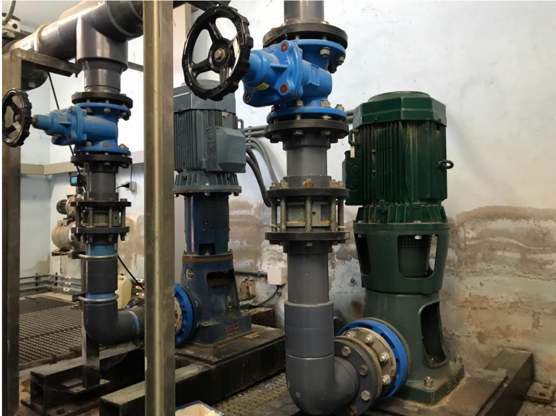
Fotografia 16. Bombes d'elevació als filtres
