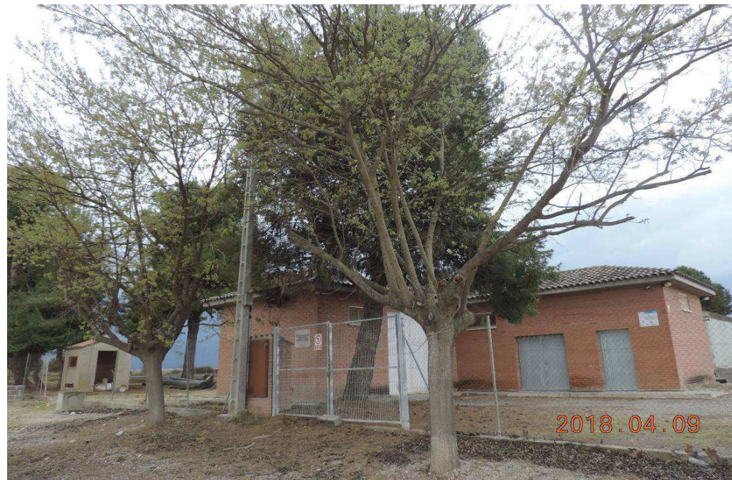
Foto 2. Edifici de l'ETAP on té lloc la potabilització des del camí Carrerada del Pla.
