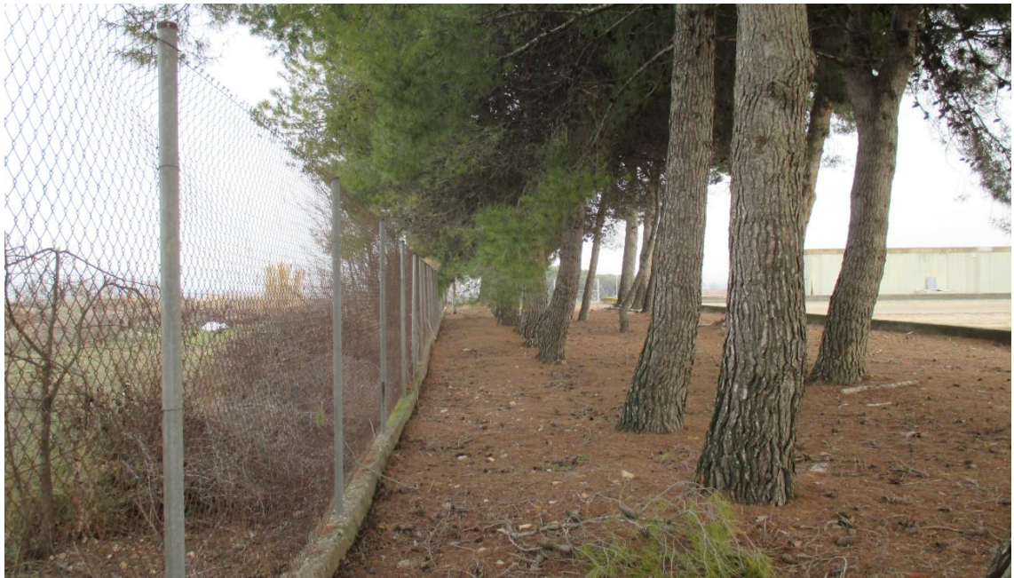
Il·lustració 10. Tanca metàl·lica a demolir al costat de la línia d'arbrat i que separa les dues parcel·les.
