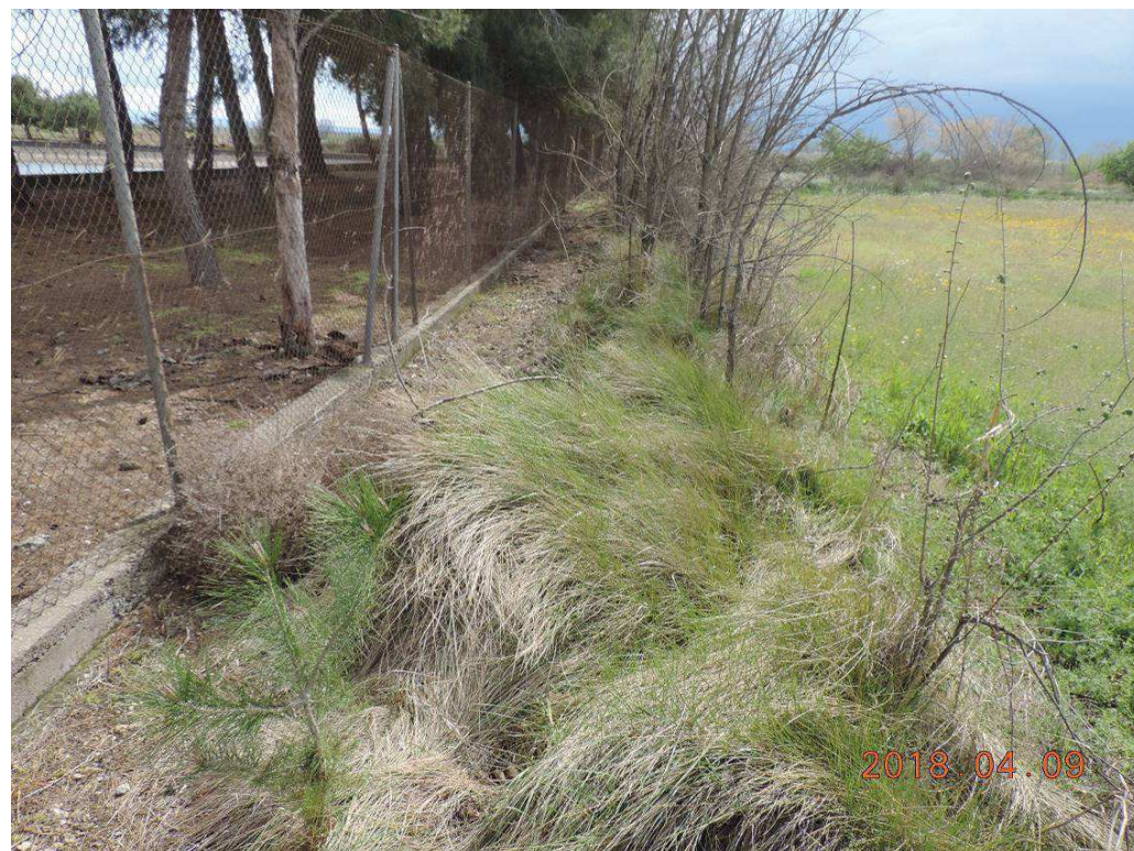
Foto 3. Recinte de l'actual ETAP vist des de l'extrem NE de l'àmbit actual.
