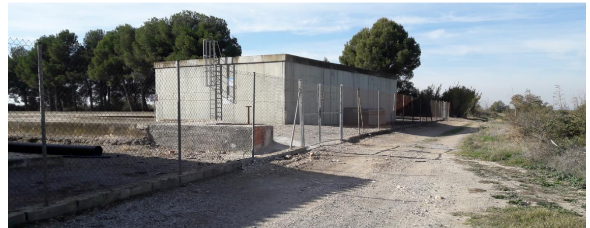
Il·lustració 8. Camí perpendicular a la carrerada del Pla. Accés a la nova ETAP.
