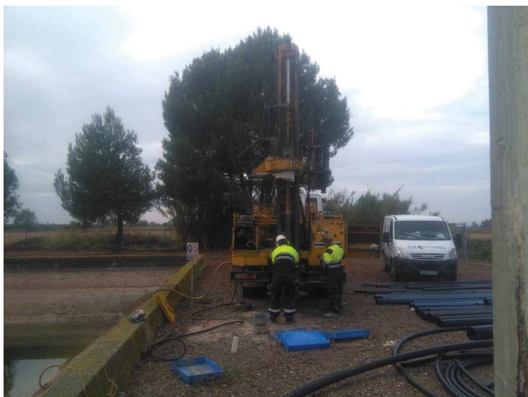
Fotografia 5: Sondeig S-3 efectuat per a l'estudi de la fonamentació del dipòsit cobert de l'àmbit 1.
