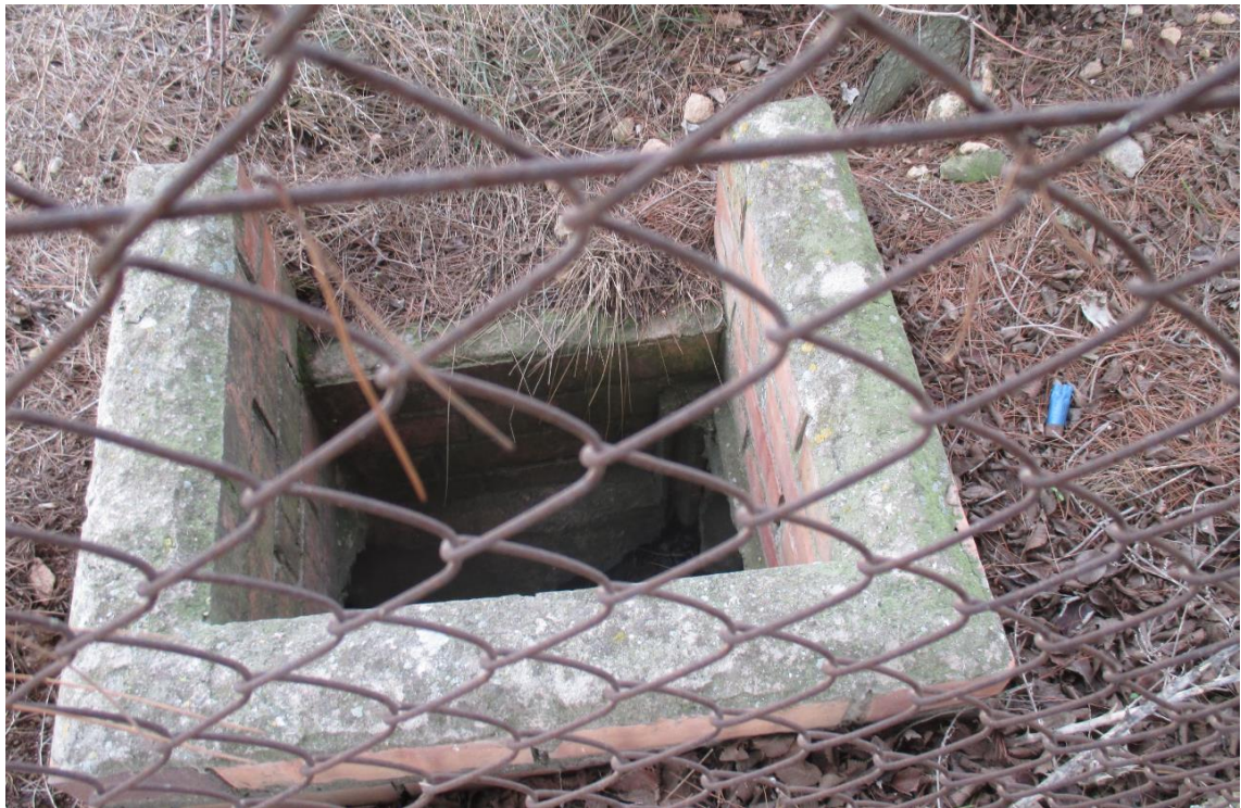
Il·lustració 9. Arqueta de registre de la sèquia que es troba al costat de la tanca que divideix les dues parcel·les.
