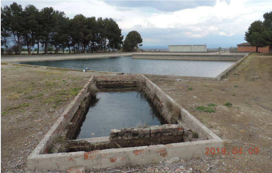
Foto 1. Vista en sentit SE-NO de les actuals instal·lacions de l'ETAP. A primer terme, l'arqueta d'entrada; al centre, la bassa d'emmagatzematge, al fons, el dipòsit d'aigua potabilitzada; i a la dreta, l'edifici on té lloc la potabilització.
